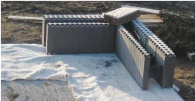
Obr. 3 Zakladanie rohov RD
