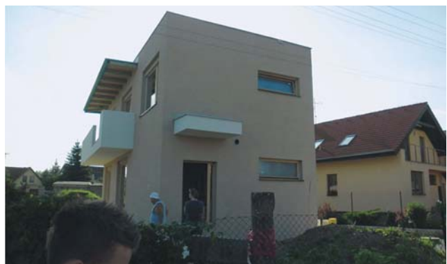
Obr. 8 Východná časť RD
