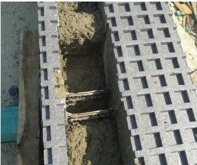
Obr. 4 Betonáž polystyrénových tvárnic
